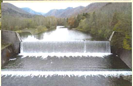
札幌内川第1号砂防堰堤
